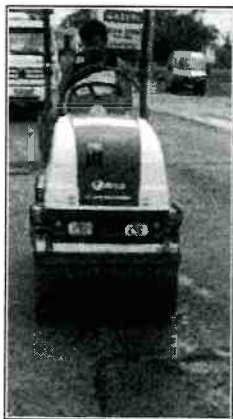
Serviço de terraplanagem
