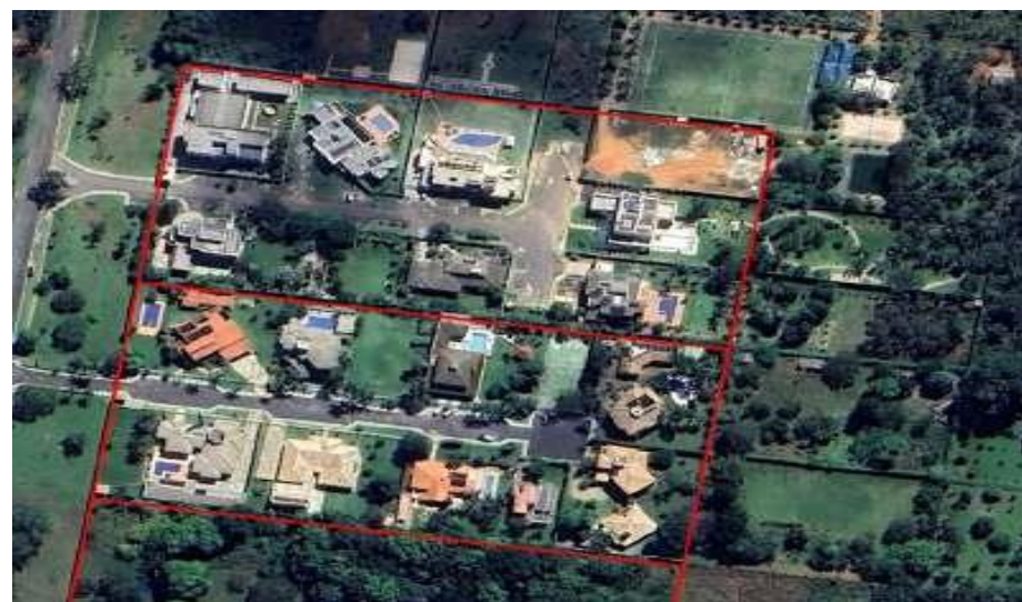
Ocupação com áreas de lazer fora do limite dos lotes no Park Way - SMPW Q 11 CJ 3
