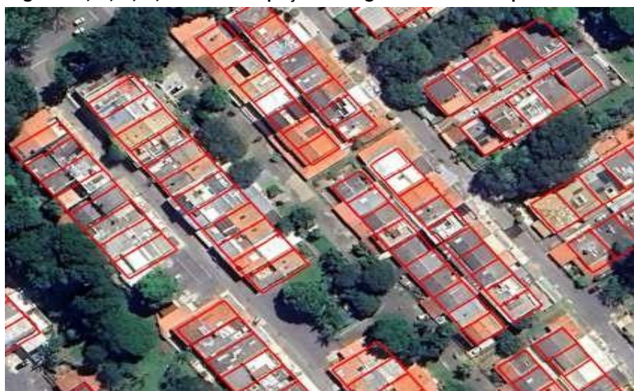
Ocupação irregular dos lotes residenciais na Quadra 713 sul - Plano Piloto
